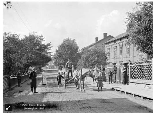
Vaasankatu Signe Branderin tallentamana sata vuotta sitten. Känäpäörin työläistaloja ja kadull kulkijoita kuvattiin vuonna 1908
